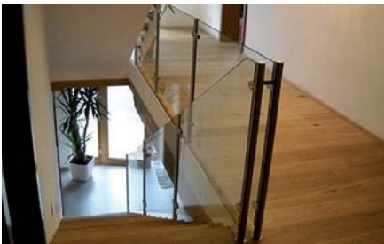
Glasgeländer als absturzsichernde Funktion für den Innenbereich, aber auch für Außenanwendung einsetzbar
